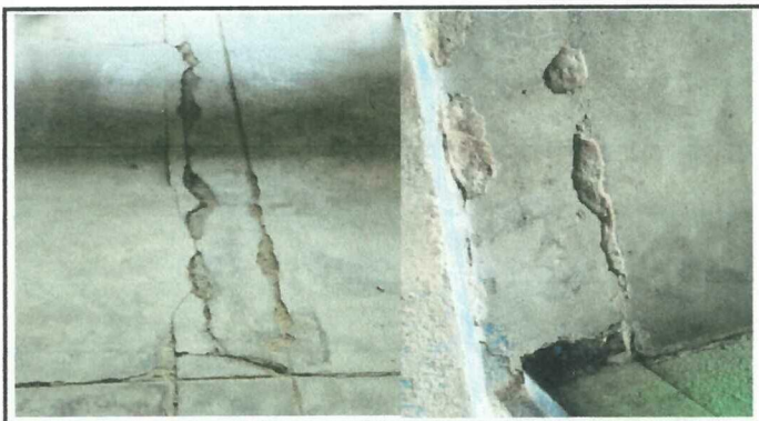
Foto 4: Reparación de piso de torta de concreto en 3 aulas y en un marco de una puerta de un aula.
