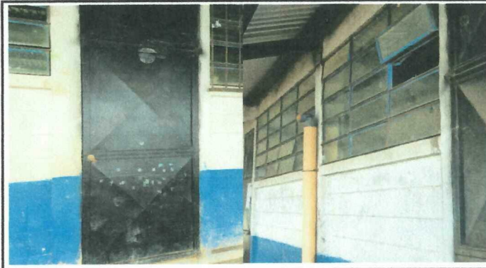
Foto 2: Mantenimiento de puertas y ventanas en un modulo de 5 aulas y dirección.
