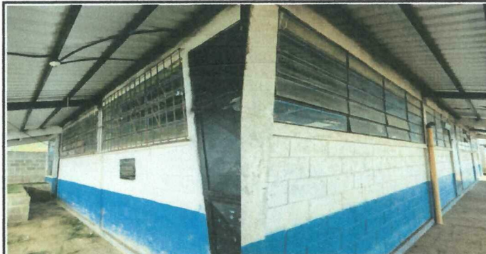
Foto 6: Sustitución de pintura en pared exterior y interior de un modulo
