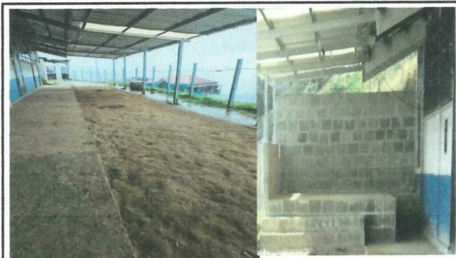
Foto 3: Rehabilitación de torta de concreto en el pasillo del modulo 1 y repello del escenario.
